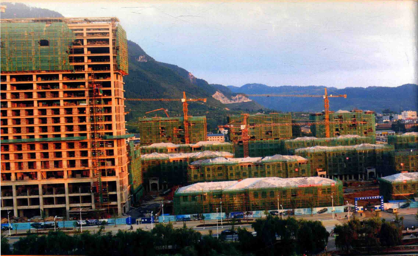
建设中的“诗乡映象”小区
