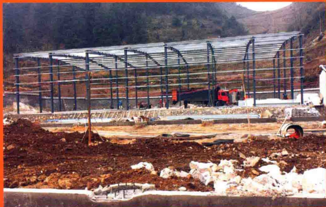
建设中的遵义旭强塑料公司厂房
