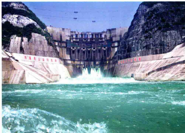
构皮滩水电站
