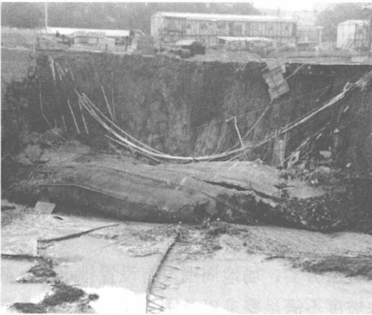
图 1-3 基坑滑坡
