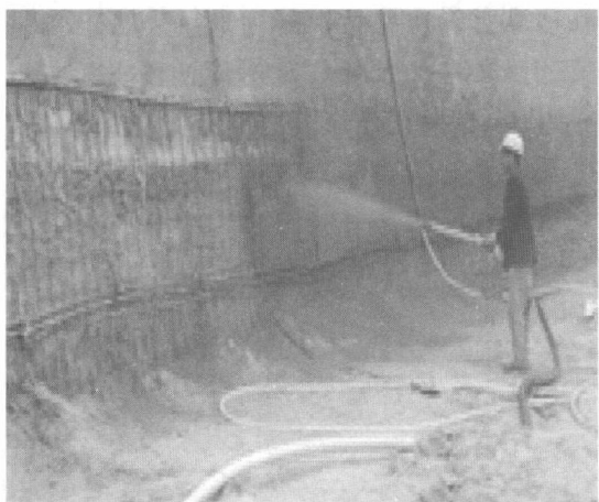
图 1-7 基坑喷浆护坡及时
