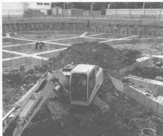
图 1-10 回填土料不符合要求 (一)
