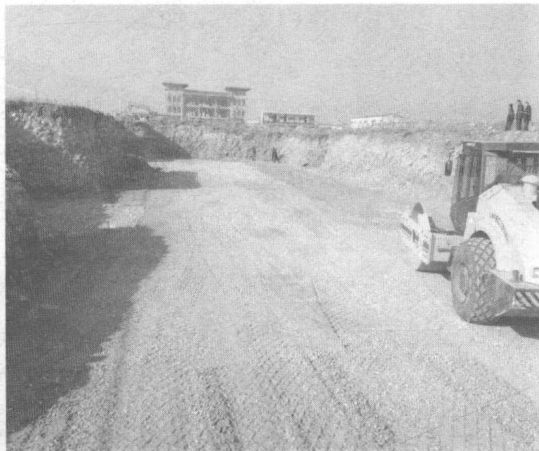
图 1-21 砂石碾压工序合理
