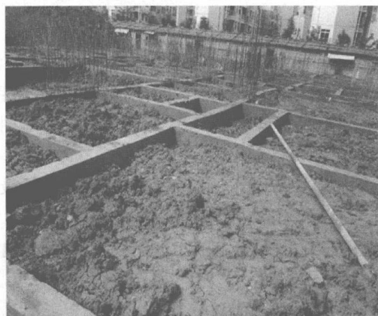
图 1-13 回填土料中含有腐殖土
