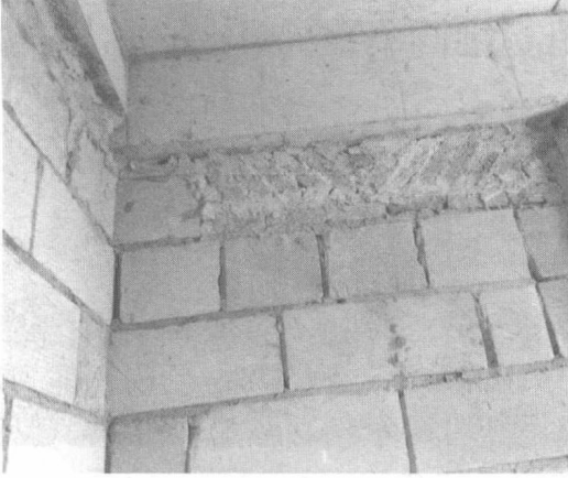
图 2-1 组砌方式不正确
