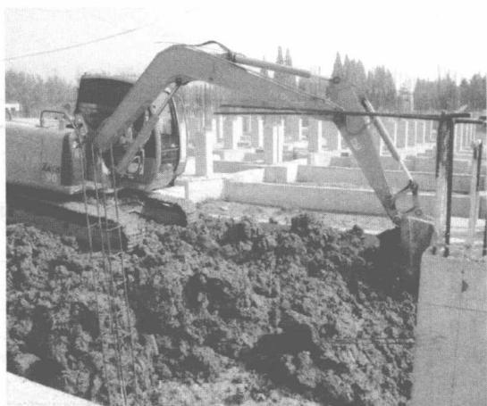
图 1-12 回填土料含水量大, 不符合要求
