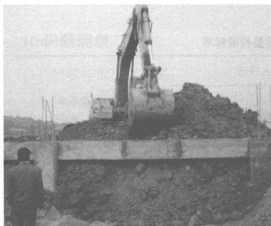
图 1-11 回填土料不符合要求 (二)
