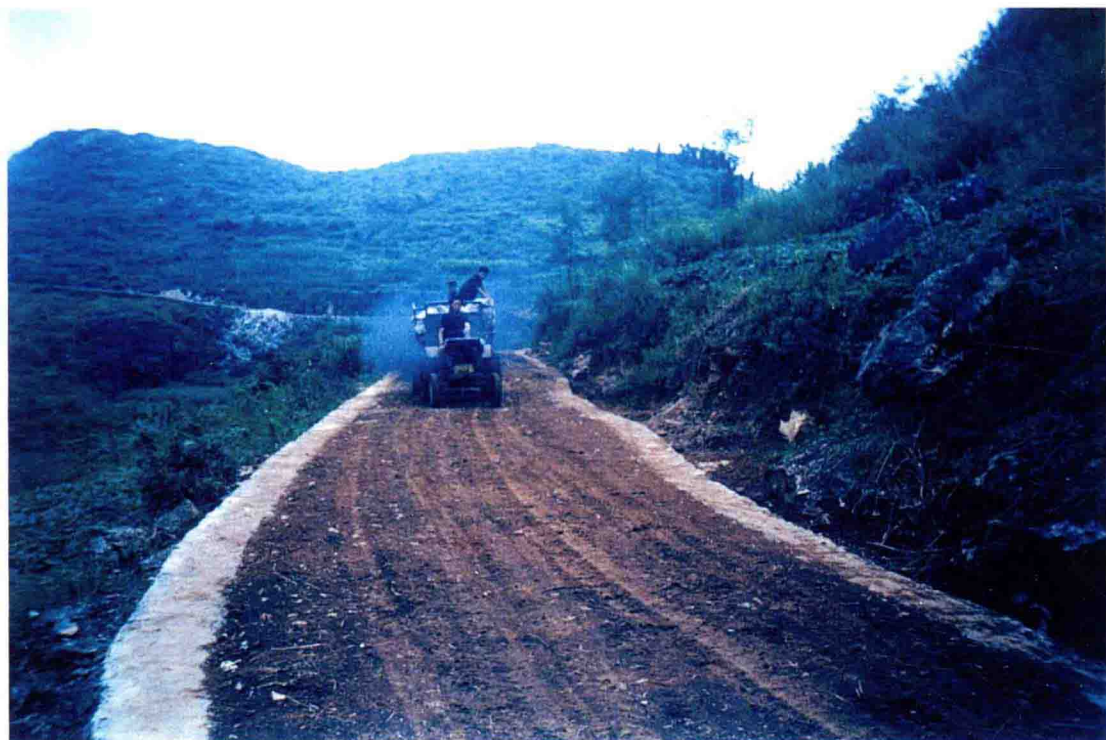
2005年4月，龙坪镇小湾村扶贫公路施工现场
