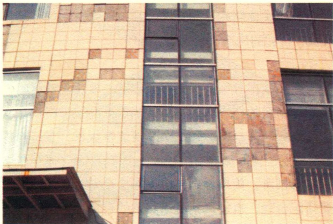
图1-27 墙面砖脱落
