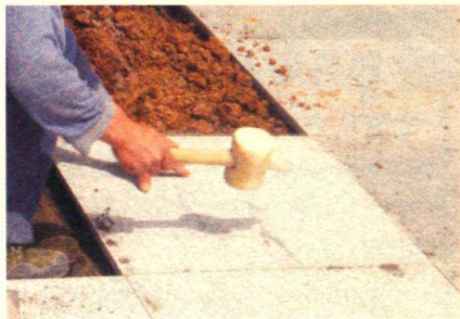
图1-34 石材铺装施工
