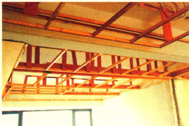
图1-47 吊顶基础构造
