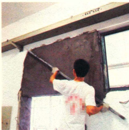
图1-40 内墙抹灰找平
