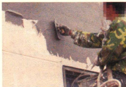
图1-35 外墙抹灰施工
