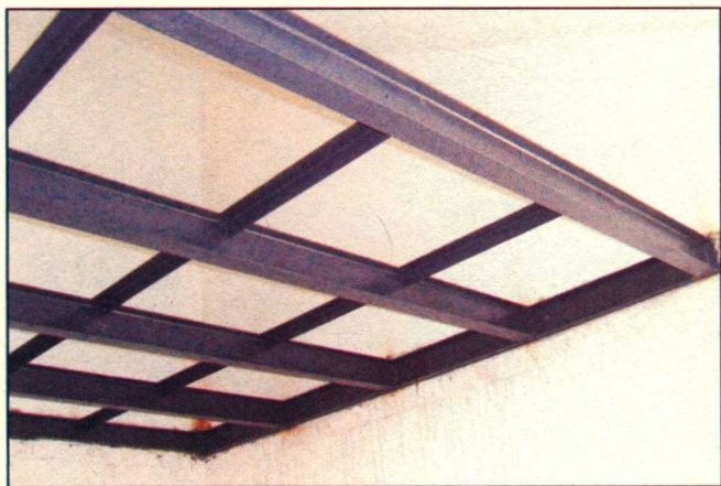
图1-38 型钢结构焊接楼板
