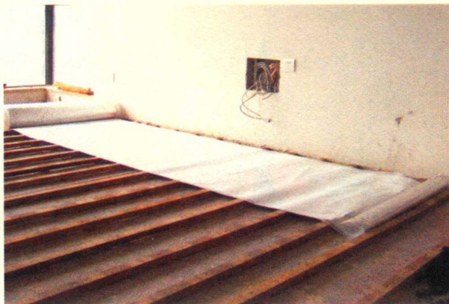
图1-39 木地板龙骨上铺装防潮毡
