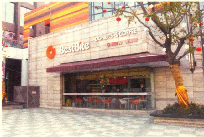
图1-17 店面外墙装修
