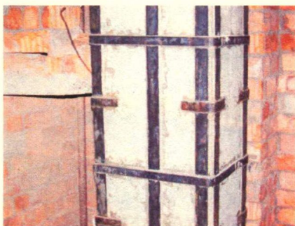
图1-49 加固立柱结构
