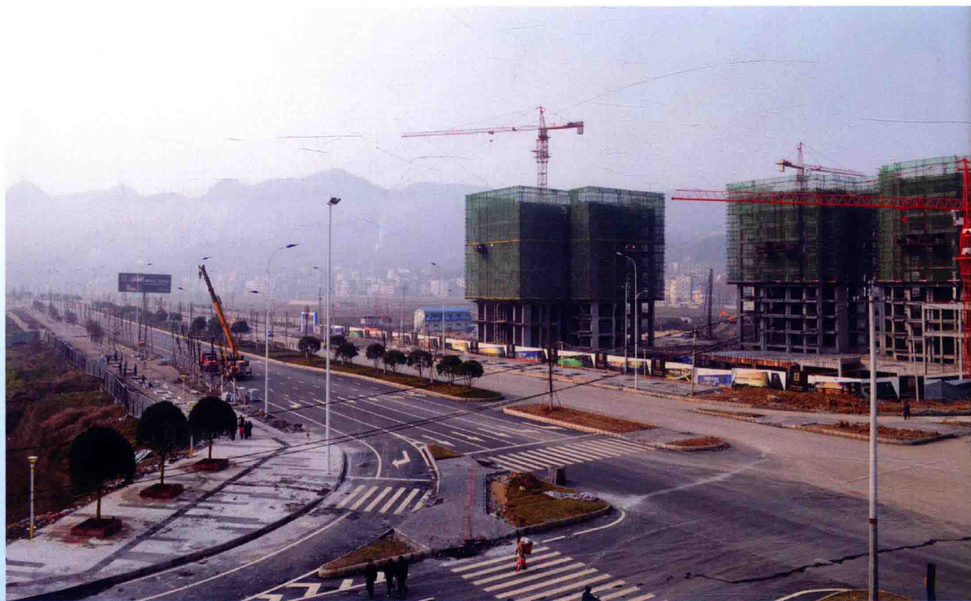
建设中的蟠龙新区一角
