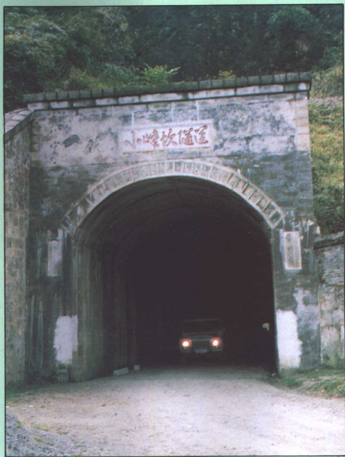
贵州公路建设的第一座 隧道——小峰坎隧道
