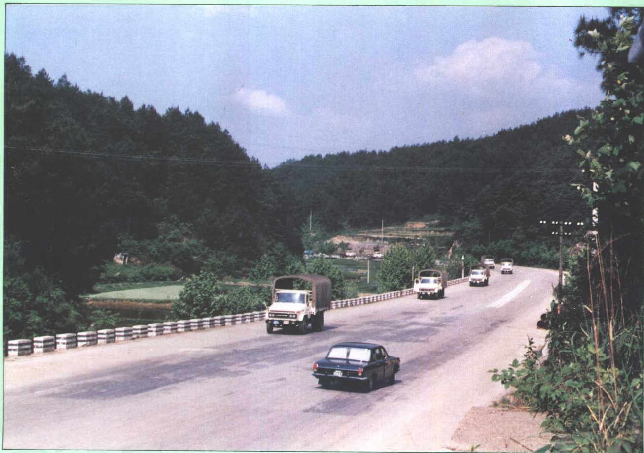
贵阳—开阳二级公路出口线
