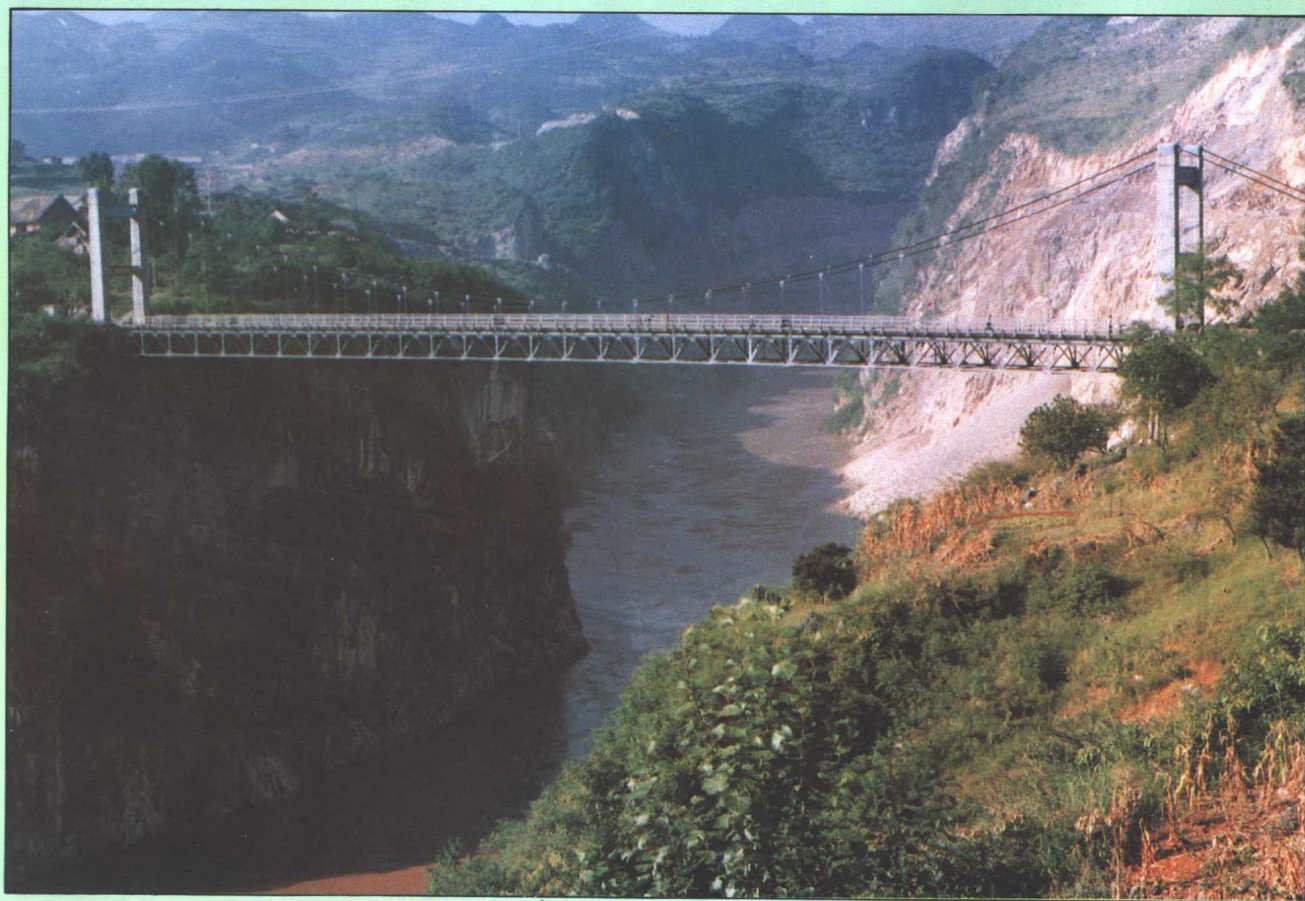
清毕公路上的鸭池河吊桥
