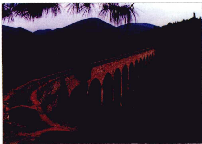
岩鹰山水库三号渡槽
