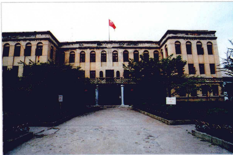
修文县人民政府办公楼
