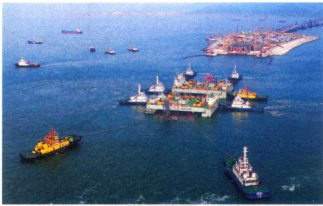
2016年10月8日，首节曲线沉管E33浮运安装
