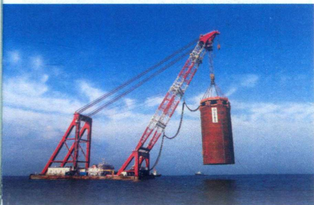
2011年5月15日，西人工岛首个钢圆筒顺利振沉
