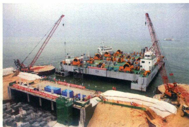
2013年5月6日，首节沉管E1完成安装
