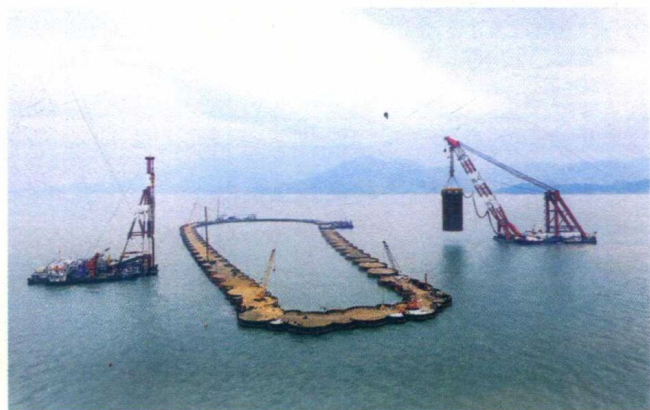
2011年12月7日，东人工岛59个钢圆筒振沉完毕，东人工岛成岛
