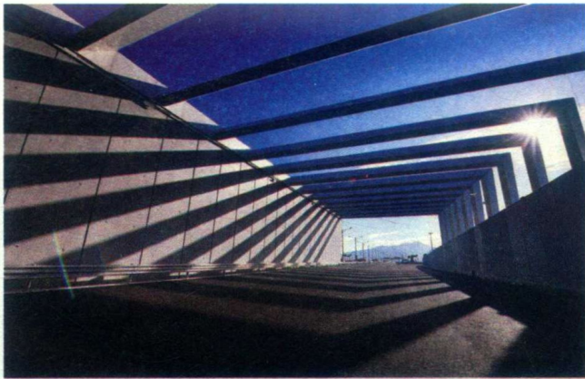
2016年12月24日，东人工岛减光罩安装完成
