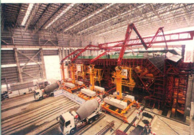
2012年8月7日，首节沉管完成混凝土浇筑
