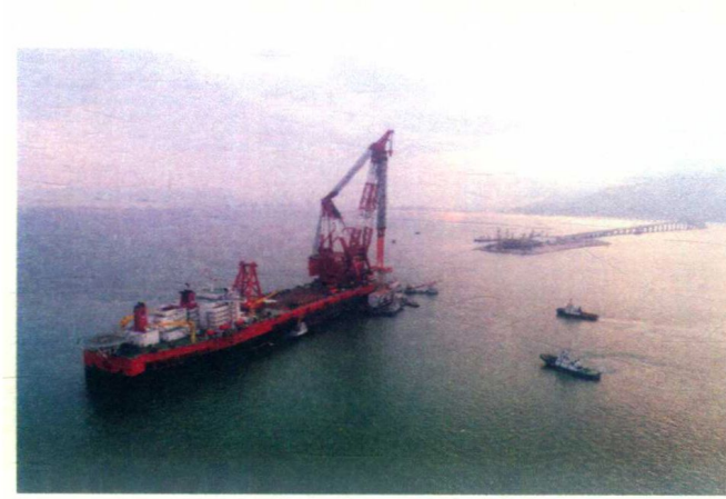
2017年5月2日，“振华30”实施最终接头安装
