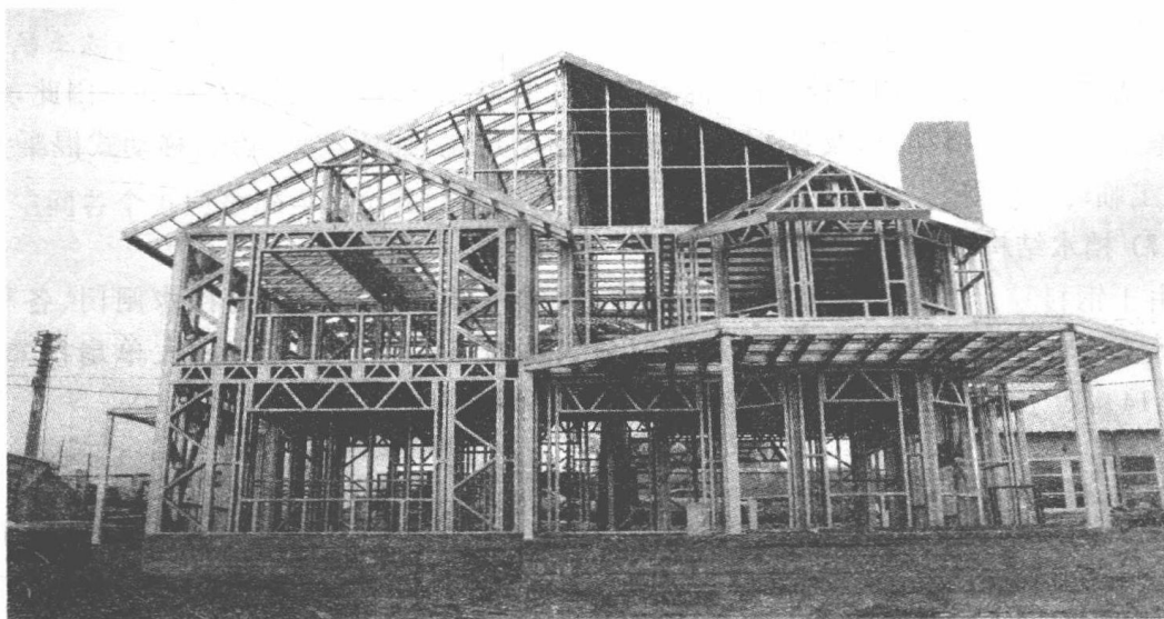
图 1.11 冷弯薄壁型钢结构
