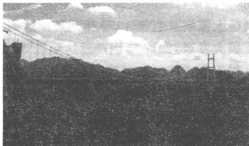
图 1.6 矮寨特大悬索桥
