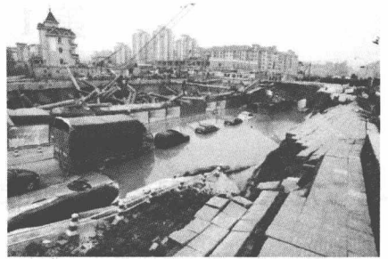
图 1.1-4 杭州地铁基坑坍塌事故
