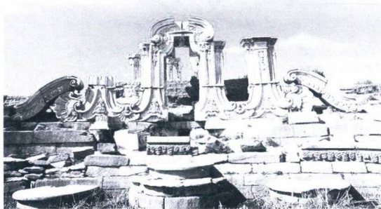
图 1-2 圆明园建筑遗址
