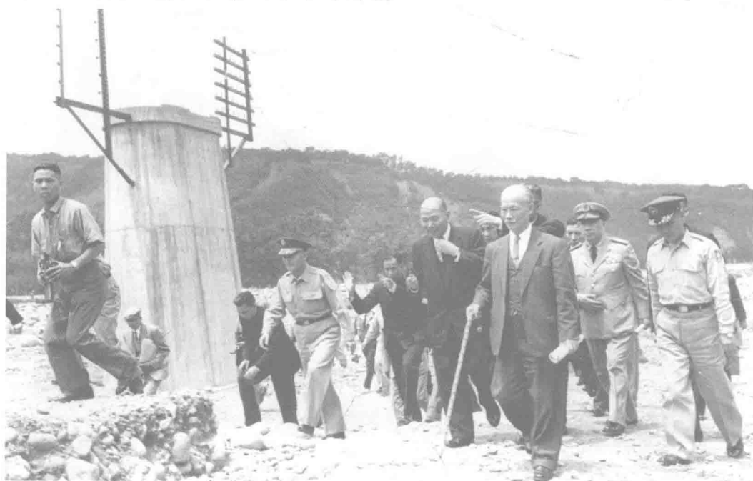
四十八年八七水災發生後，鐵公路受破壞嚴重，陳誠指示迅速進行搶修，並親赴各地視察鐵路橋樑重建工程進行情形。
