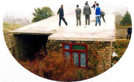
拆除违章建筑
