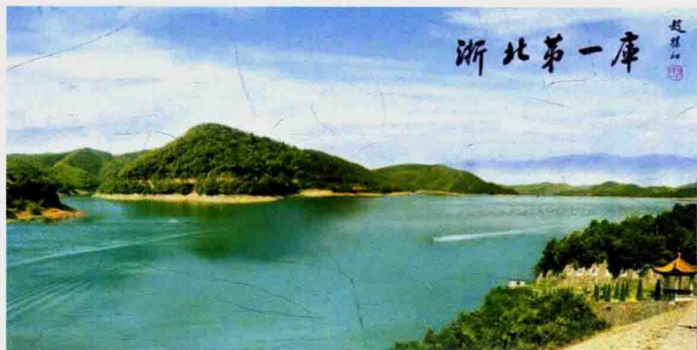
总库容2.18亿立方米的赋石水库
