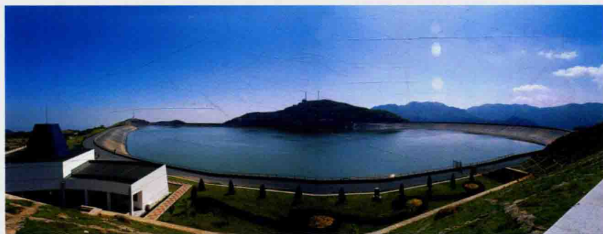
天荒坪抽水蓄能电站上水库
