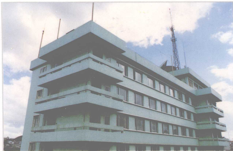
贵州省气象局业务大楼
