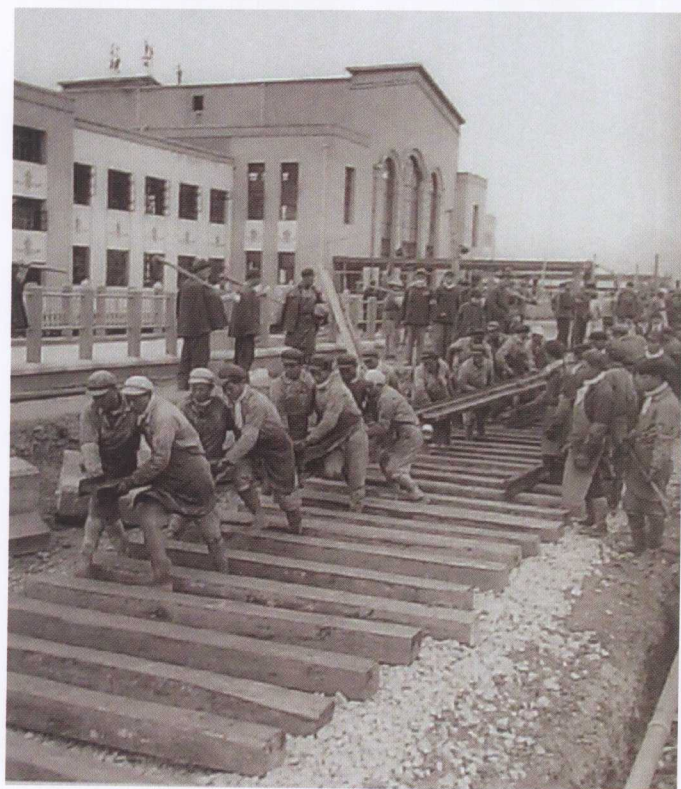
◀ 1958年12月，黔桂铁路铺轨到贵阳。
