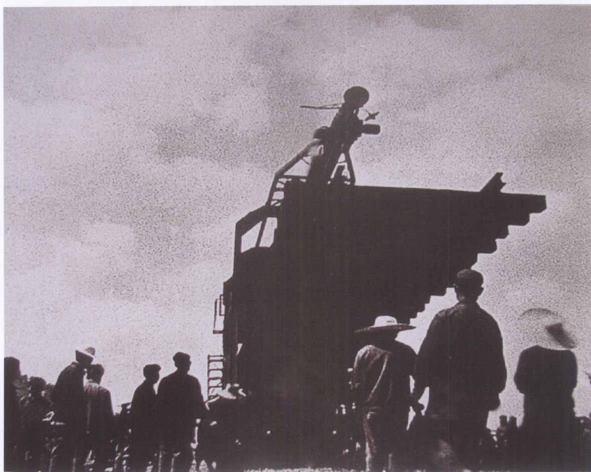
▲ 1968年，湘黔铁路建设大会战。图为贵州段铁路铺轨现场。
