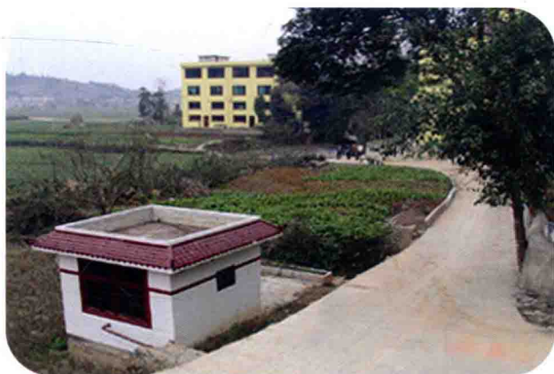
龙家镇文家湾人饮解困工程——提水站
