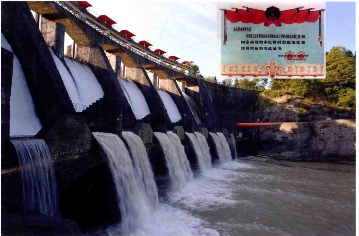
团结水库大坝工程
