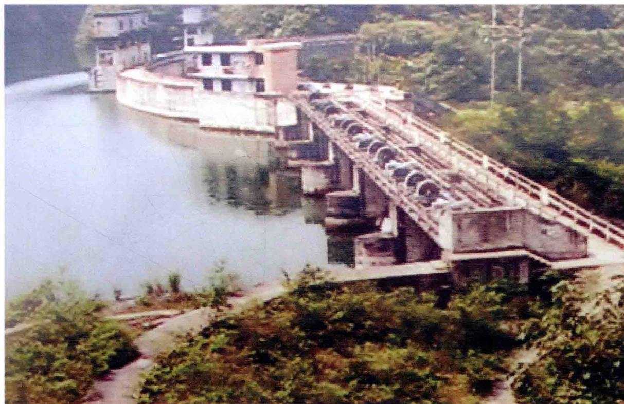
方竹电站水库大坝工程
