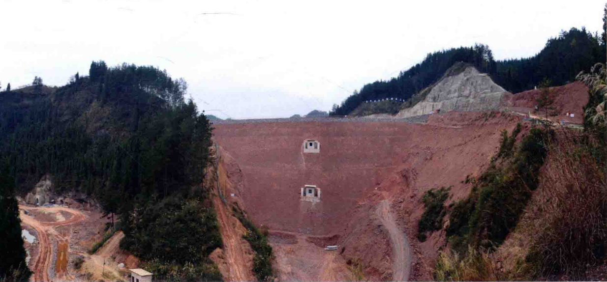
在建中的魁龙水库大坝工程
