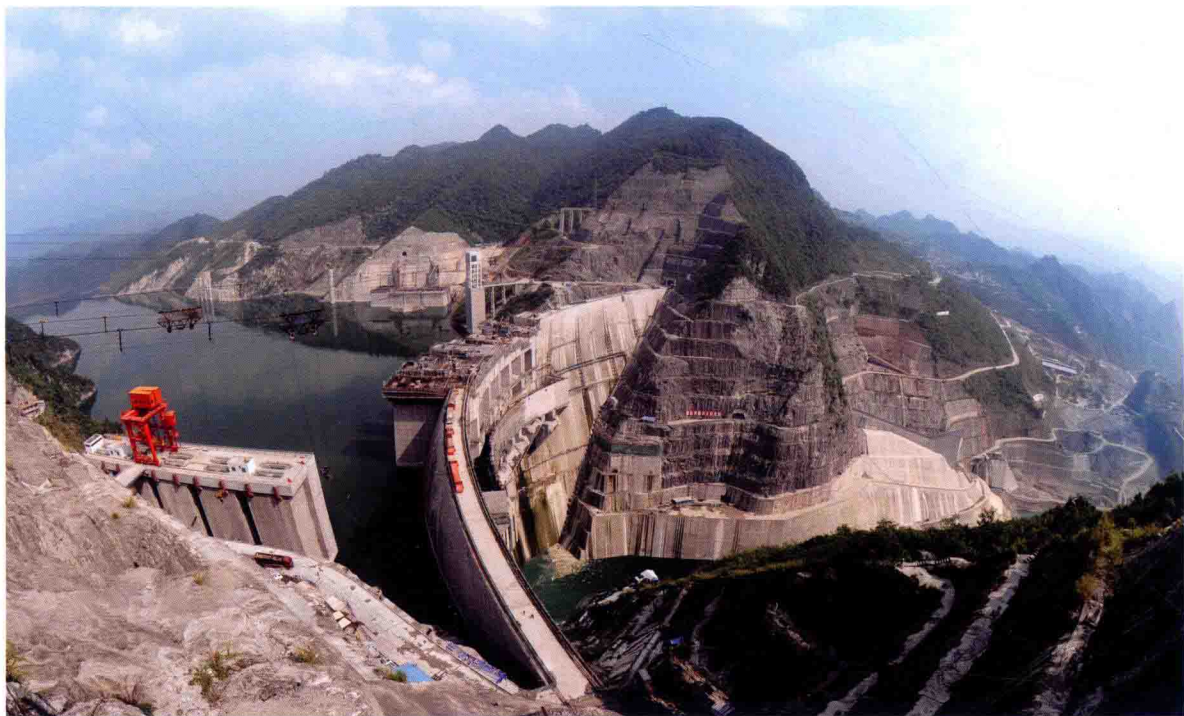
乌江构皮滩水电站——为贵州省西电东送标志工程，于2003年11月8日正式开工建设，2009年5台机组全部建成发电，总装机容量300万千瓦
