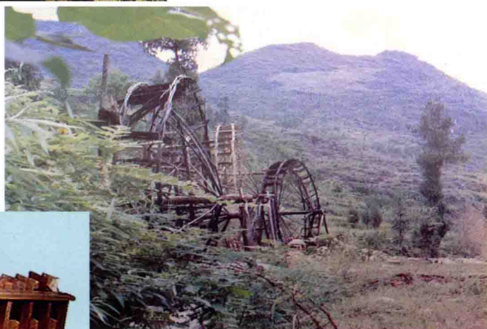
20世纪50年代使用的提水工具——筒车
