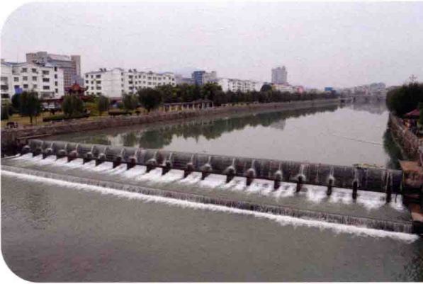
余庆河防洪翻水坝工程
