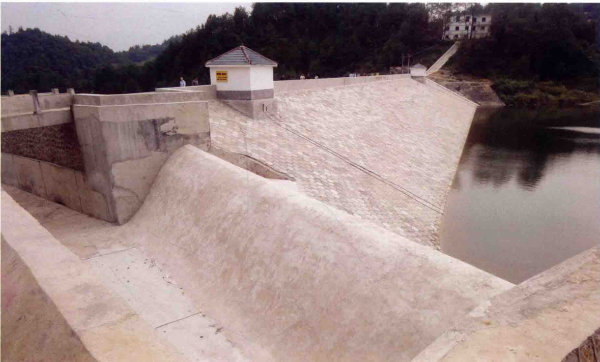
李家寨水库大坝加固工程
