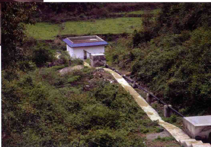
农村电力提灌站
