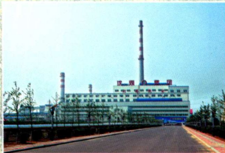
沈煤集团灯塔热电厂
