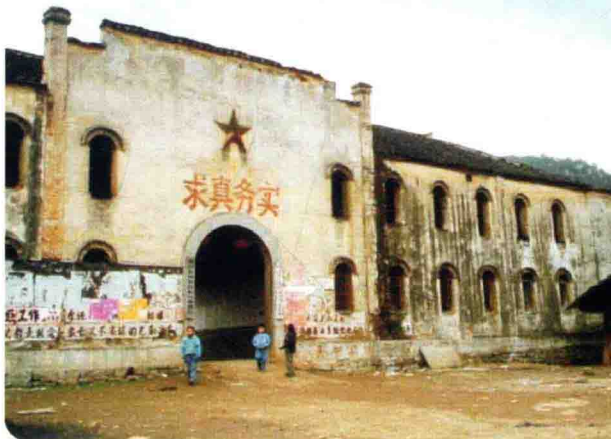
民国时期修建的凤冈县新岗村政校
