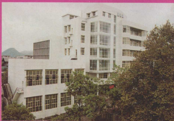
黔南州师专图书综合楼
