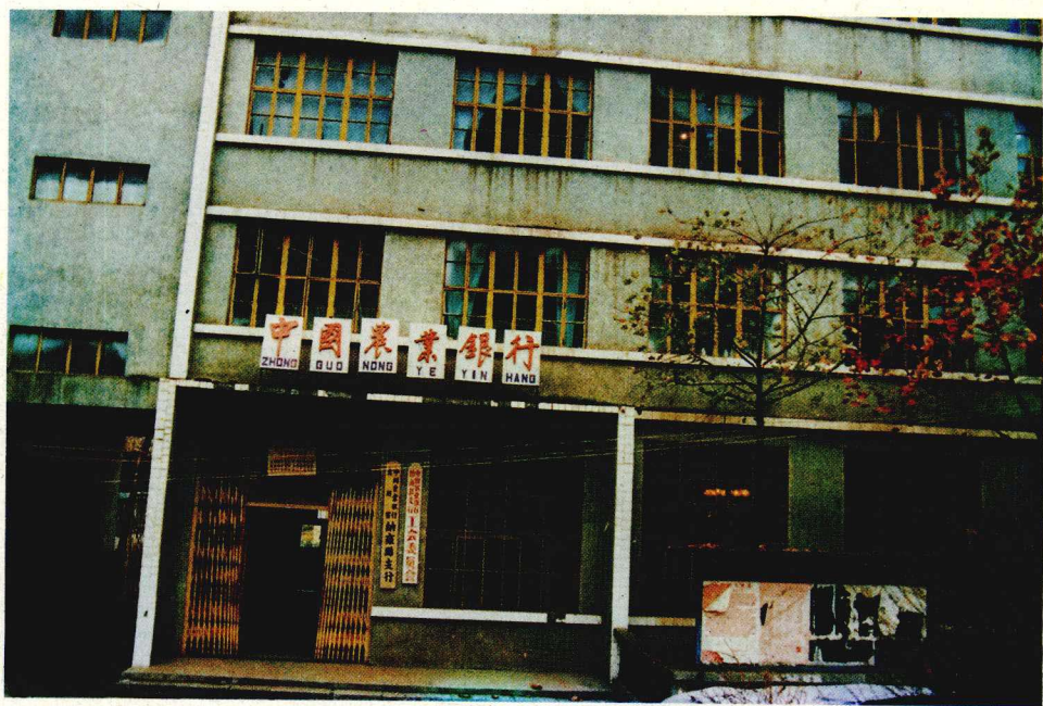
▲ 纳雍支行办公楼
