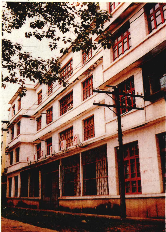
▶ 威宁支行办公楼。
