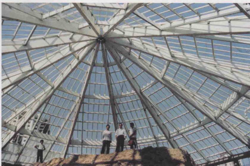
◀我院木材所研制的胶合剂用于康乐宫嬉嬉水乐园大跨度胶合木结构工程，是我国目前最大的胶合木结构，国内首创、达到国际水平。
