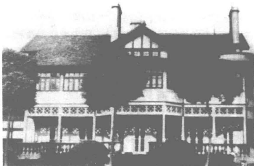
南京西路铜仁路口,上海工人民兵指挥部所在地。
