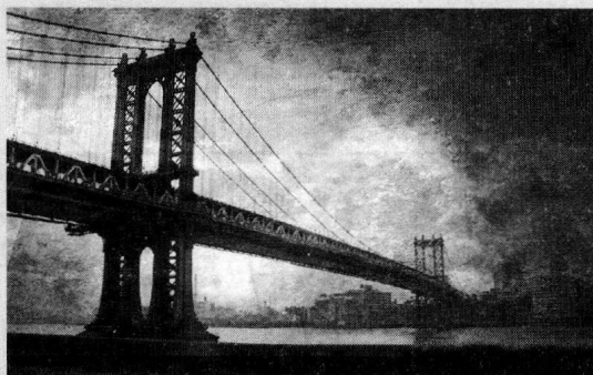
图 1.9 金属结构桥梁
