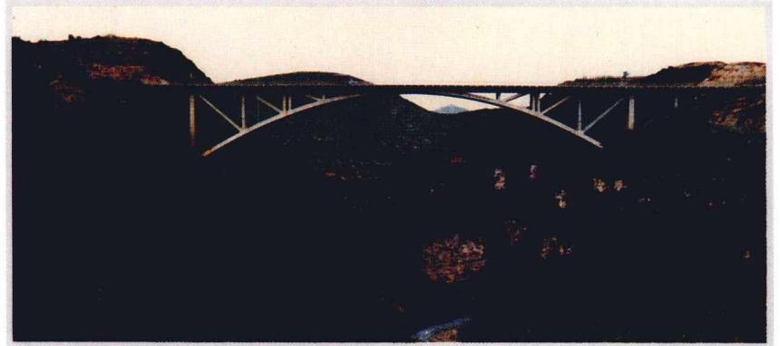
贵毕公路归化大桥
