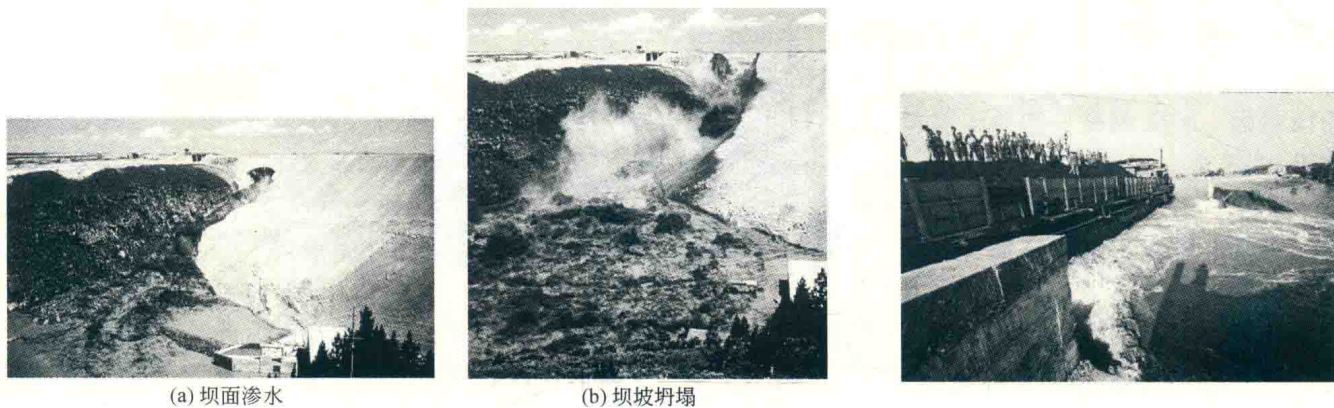
图 0.7 Teton 坝破坏过程
