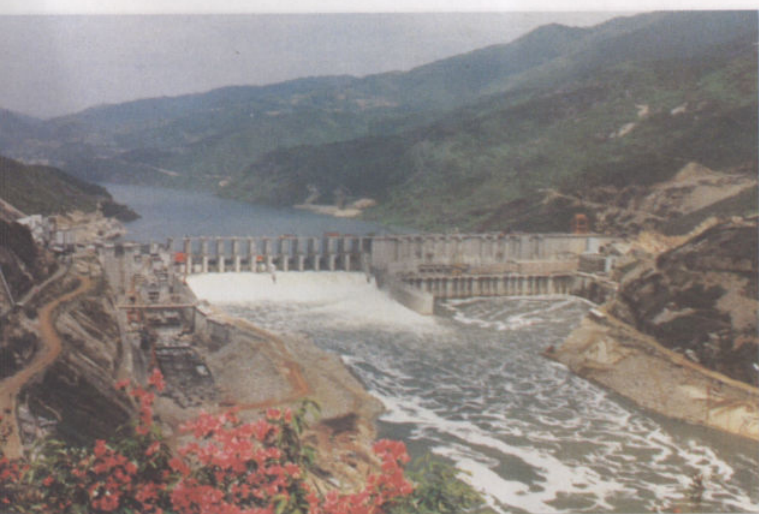
华东最大的闽清水口水电站
