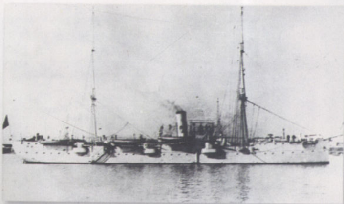
福建船政1893年制造的“通济”号钢壳军舰，排水量1900吨，马力1600匹
