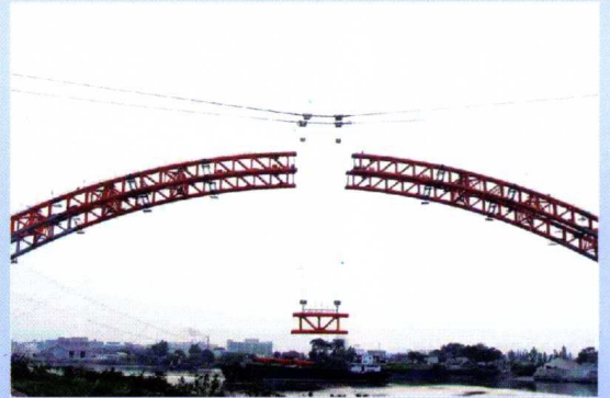
图 8.14 缆索吊装安装拱部
