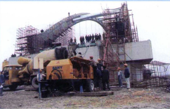
图 8.35 泵送顶升浇筑拱肋混凝土
