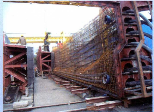
图 5.8 橡胶抽拔管
