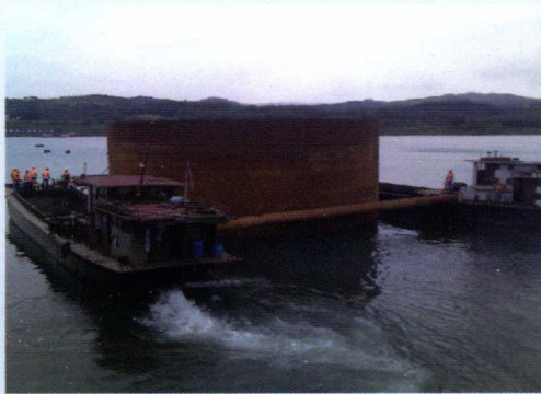
图 1.23 双壁钢围堰施工
