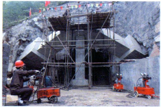
图 10.6 隧道式锚碇
