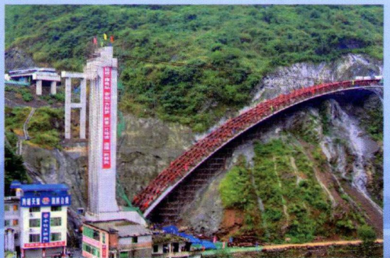
图 8.37 钢管混凝土劲性骨架
