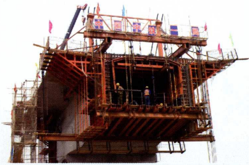
图 6.16 挂篮施工状态
