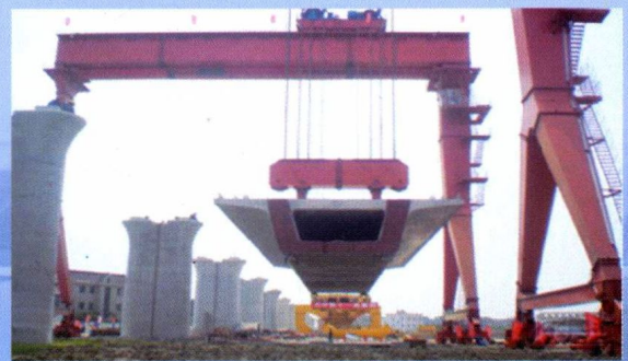
图 5.16 跨墩门式吊车架梁
