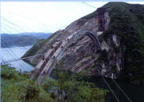
图 8.18 边段拱肋悬挂方法(c)
