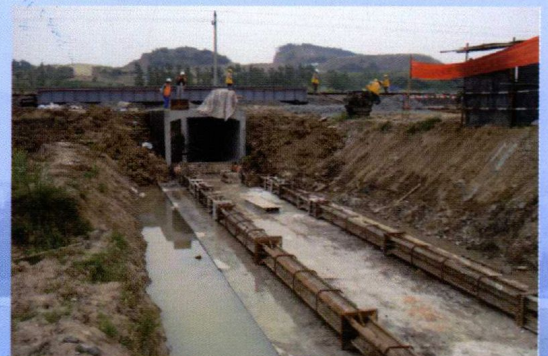
图 12.13 顶进设备及施工临时设施(b)滑板及顶铁
