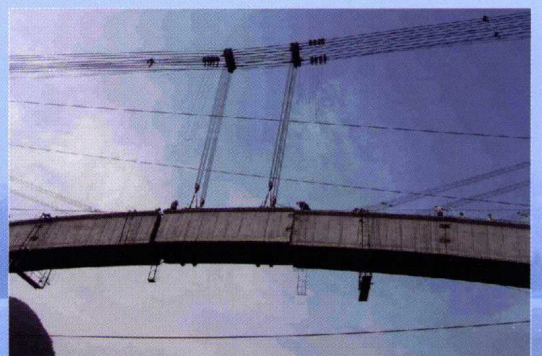
图 8.19 吊运中段拱肋合龙
