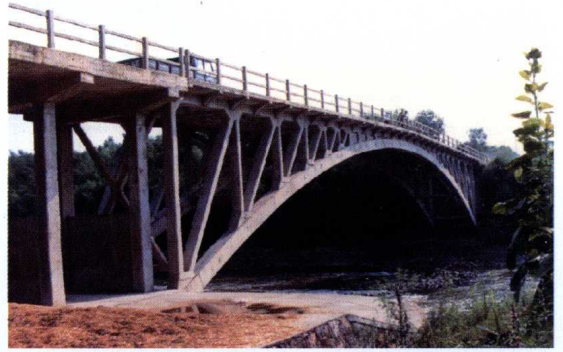
图 8.4 桁架拱
