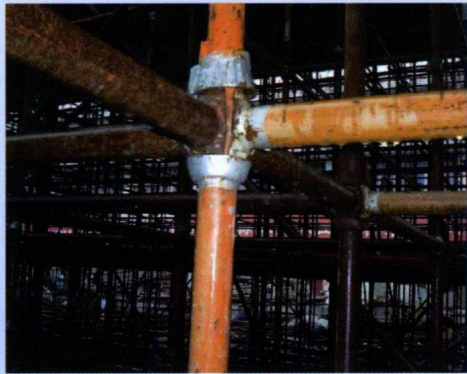
图 1.38 碗扣式脚手架
