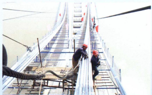
图 10.11 送丝工艺示意图
