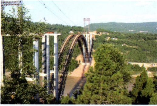
图 8.38 钢管混凝土劲性骨架合龙
