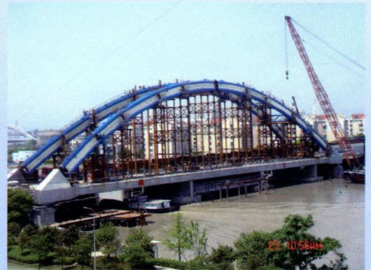
图 8.34 支架法拱肋安装
