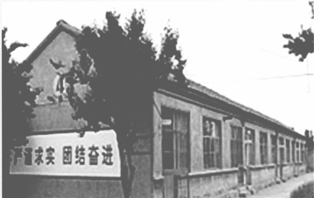
山东省临朐县原城关中学校舍
