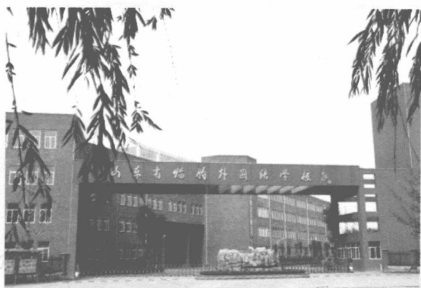
山东省临朐外国语学校正门
