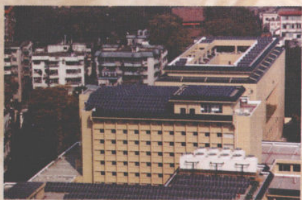
太阳能光伏发电设备
