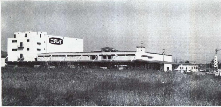
日本冷蔵盛岡工場が完成 冷凍能力は8650トン
