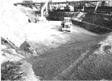
图 1.1.4.1 换填地基施工
