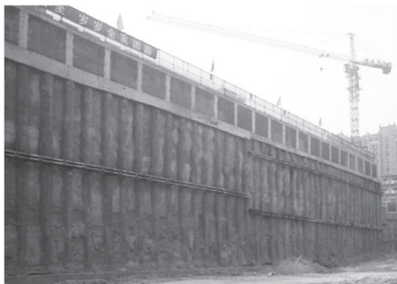
图 1.3.1.1 支护桩开挖固定
