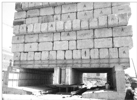
图 1.3.2.1 试验桩承载力检测
