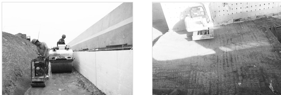
图 1.1.1.1 回填土分层压实
