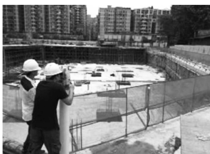
图 1.2.4.2 基坑变形检测测量
