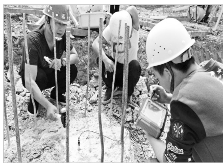
图 1.3.2.2 试验桩完整性检测
