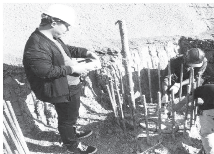
图 1.3.1.2 支护桩做完整性检测
