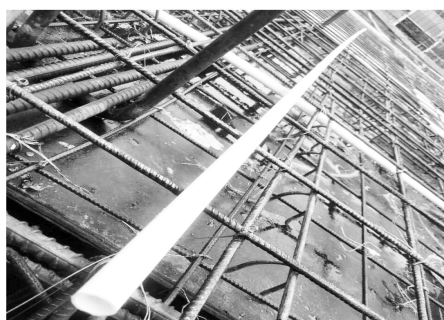
图 2.1.1.2 采用 PVC 线管控制钢筋保护层
