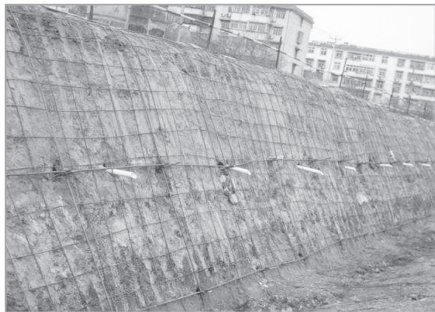
图 1.2.1.1 边坡钢筋网间距均匀
