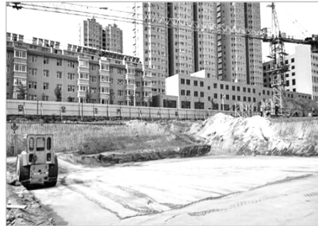
图 1.1.4.2 换填地基分层压实
