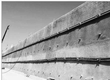
图 1.2.3.2 边坡养护到位混凝土密实
