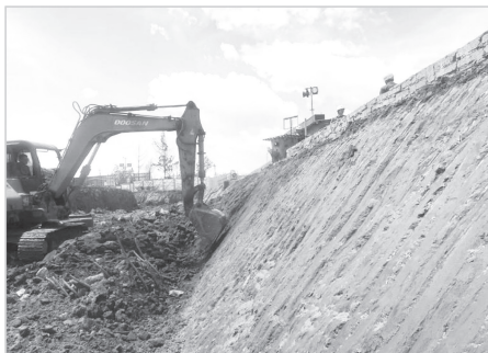
图 1.2.2.1 边坡按比例修坡
