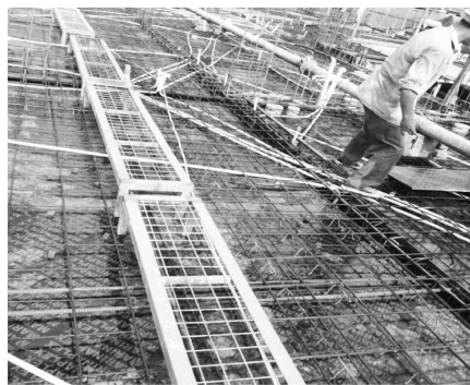
图 2.1.1.4 钢筋绑扎完毕后铺设成品马道
