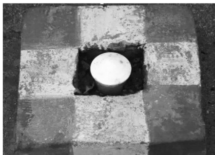
图 1.2.4.1 基坑监测点保护
