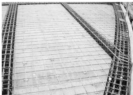
图 2.1.1.1 板底筋加设混凝土垫块
