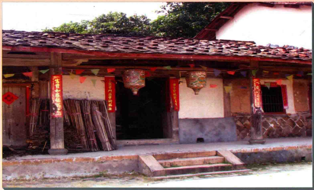
后坑岑古厅堂(重修)
