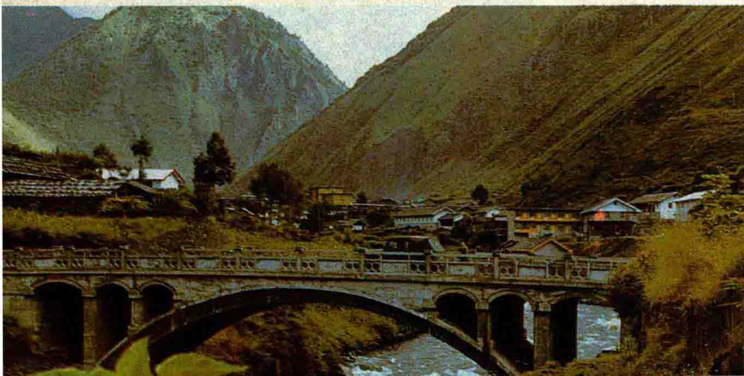
立壁桥，是我县南大门的第一座钢筋混凝土拱桥
