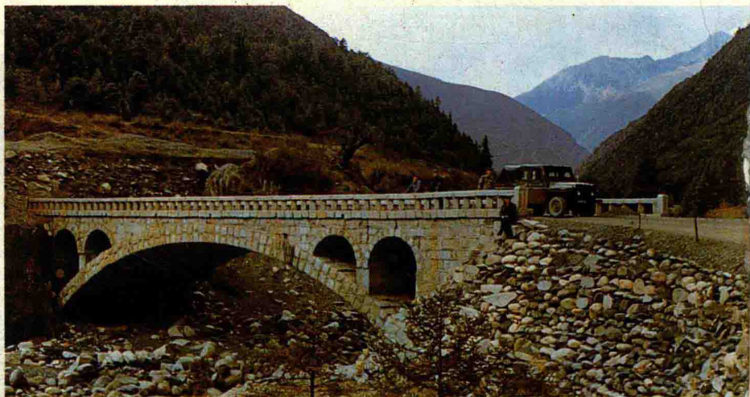
崩崩冲桥是我县北大门的第一座石拱桥。
