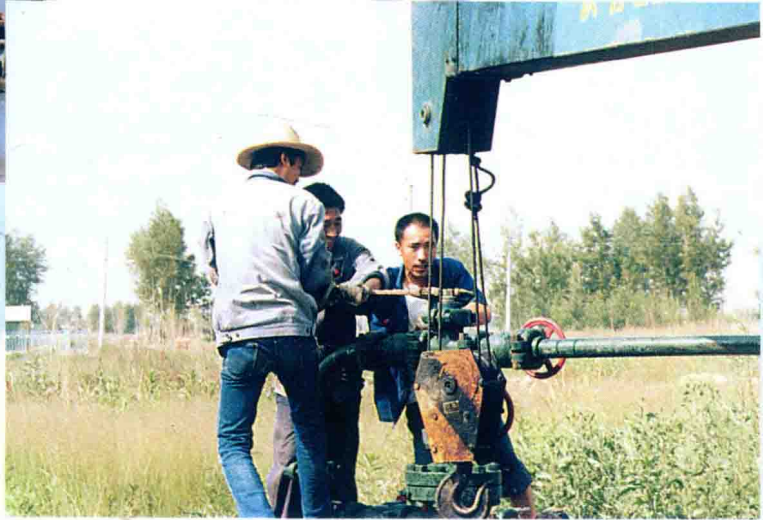
注水井口维修
