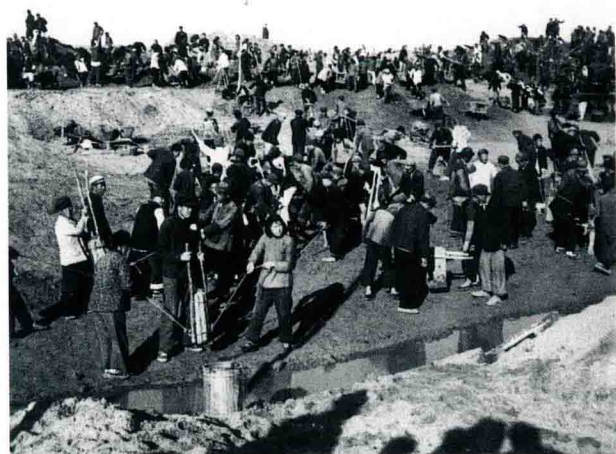
产芝水库大坝回填
