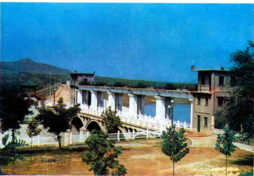
北墅水库溢洪闸
