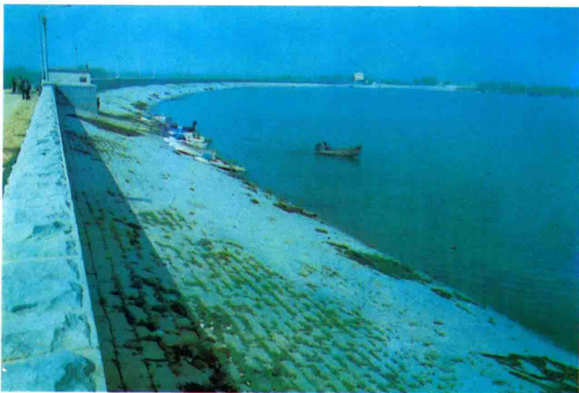
高格庄水库大坝
