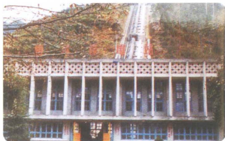
郴州市明星乡镇企业——苏仙区雷溪坝电站
