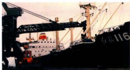
贵州煤炭从这里运往世界各地—湛江港煤码头
