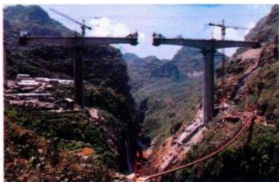
南昆铁路黔西南段清水河大桥 采用最新悬灌技术建造的世界 最高的铁路大桥
