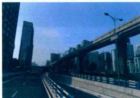
图 1-1-13 跨座式单轨交通不同的敷设方式图
