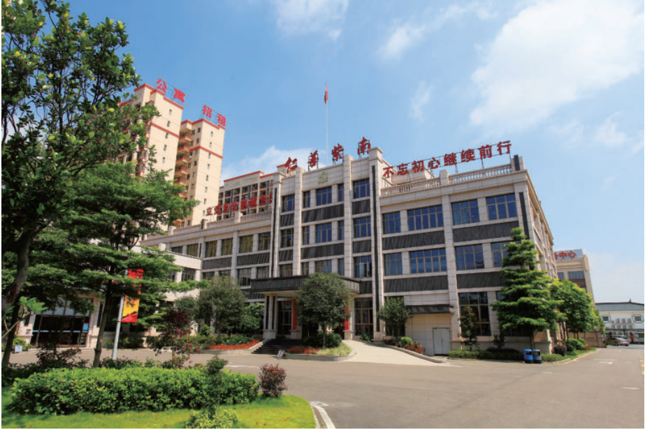
紫南村委会、紫南集团有限公司办公楼
