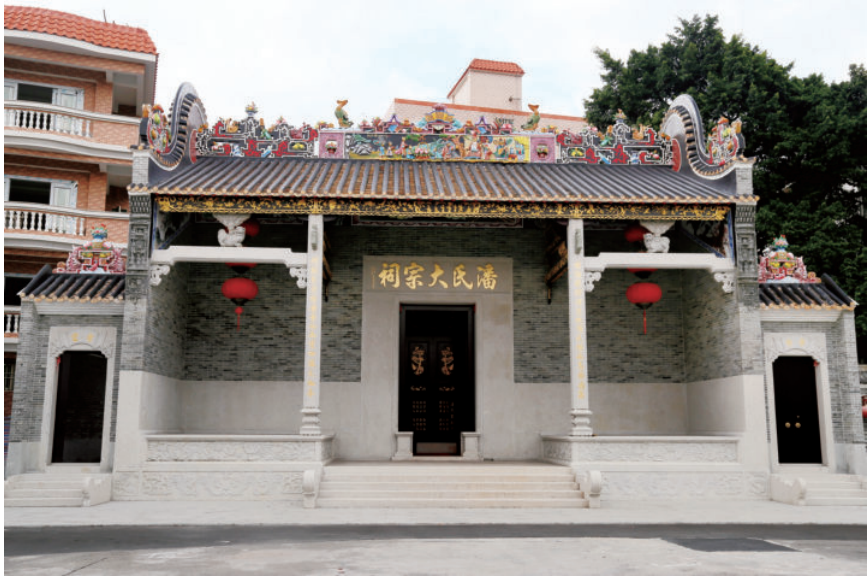
充美村祠堂，采用具有岭南特色建筑的硬山顶锅耳式封火山墙。 紫南村现有可供观赏的祠堂20余处。
