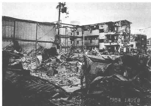
图 1.3 地震的危害（阪神、淡路大地震，摄于 1995 年 1 月 31 日）
