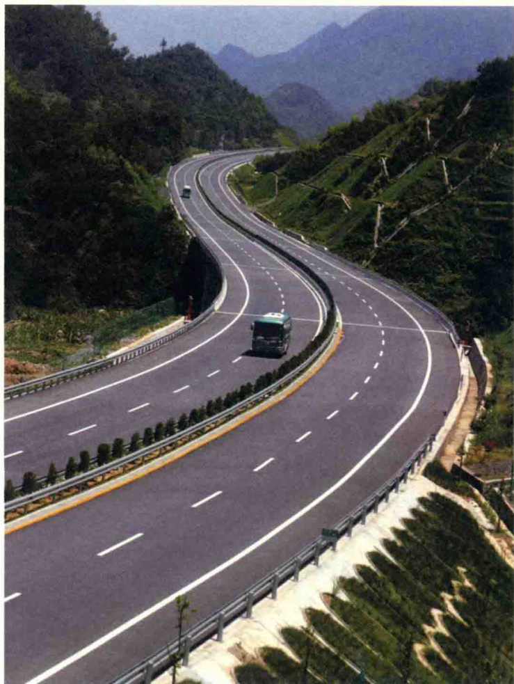
图2 G50 杭瑞高速公路杭州昌化昱岭关路段
