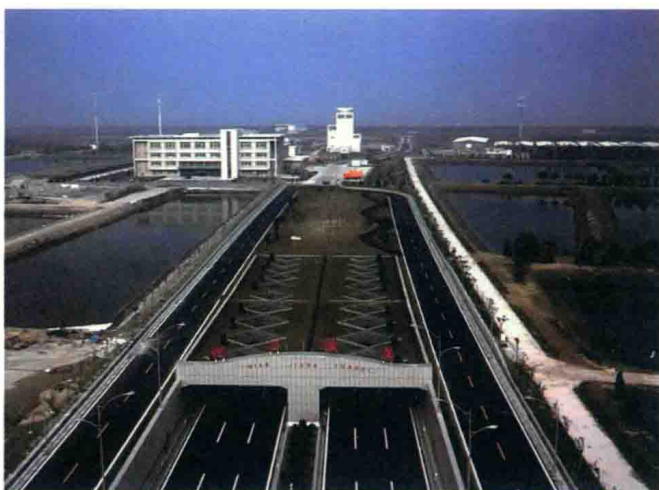
图19 钱江隧道 (S9 钱江通道)
