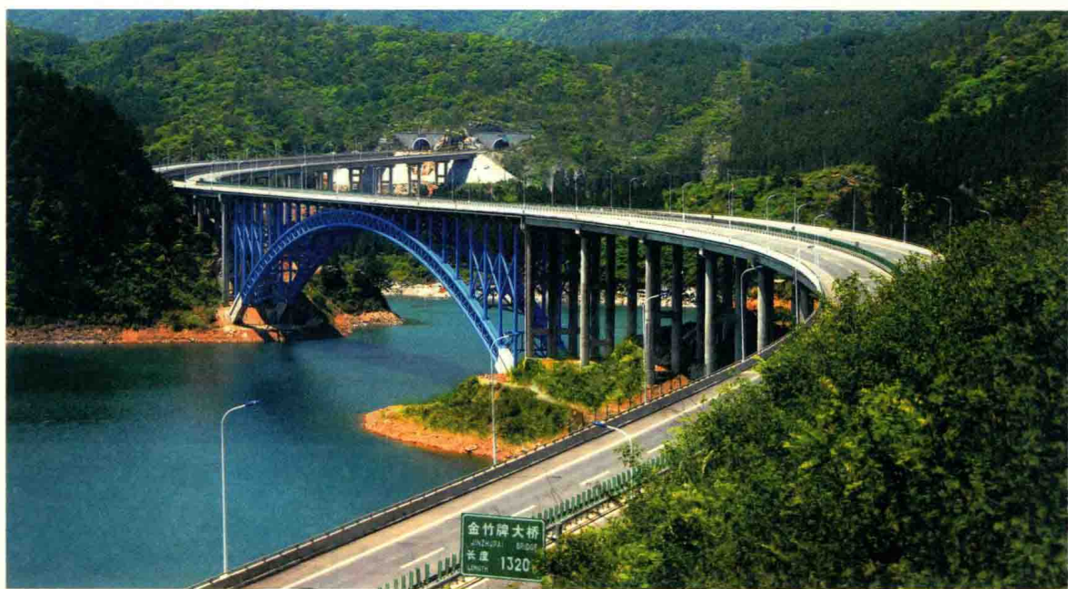
图16 金竹牌大桥 (G4012 溧宁高速公路)
