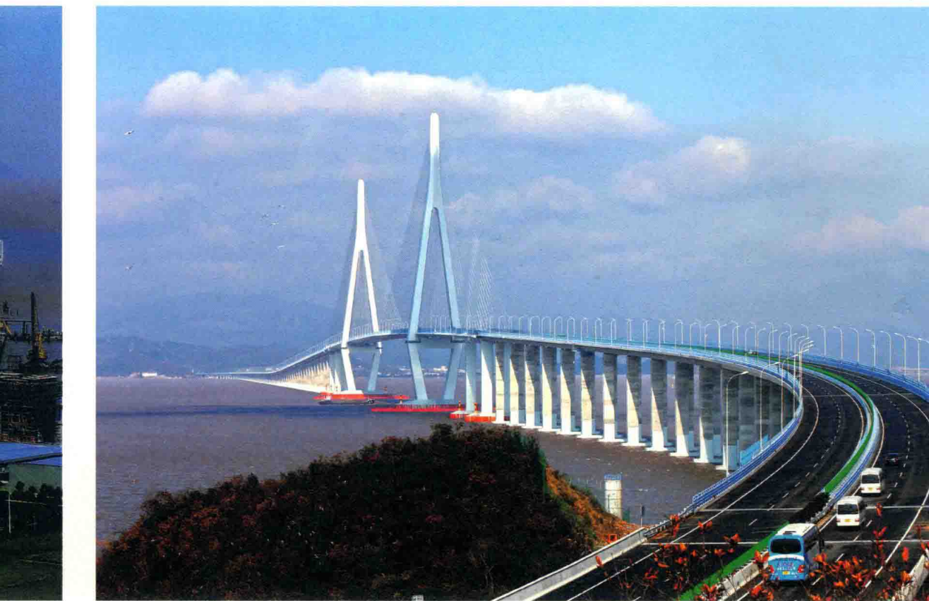
图12 象山港大桥 (G15W3 宁波至东莞高速公路)
