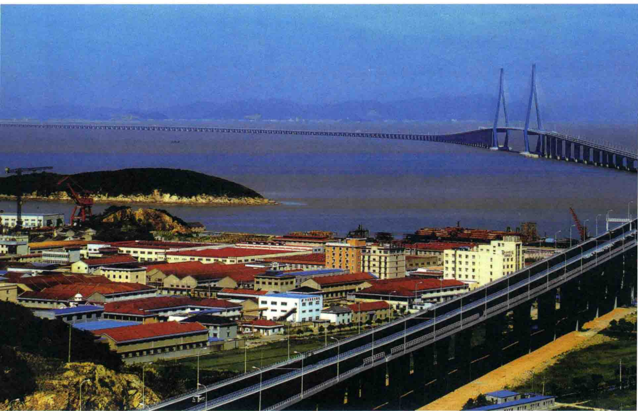
图11 金塘大桥 (G9211 甬舟高速公路)
