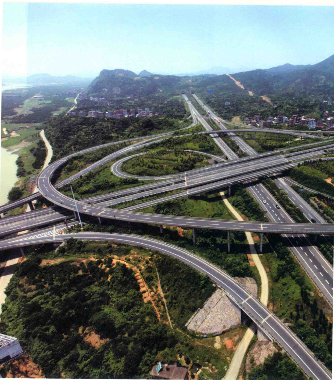
图6 五里枢纽 (G3 京台高速公路 +G60 沪昆高速公路)
