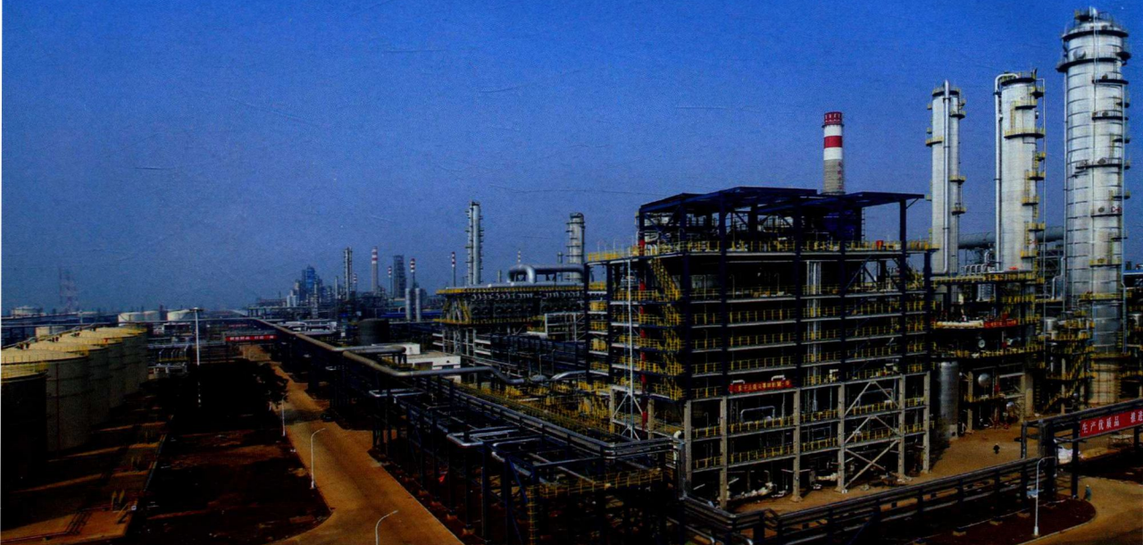
海南炼化 310 万吨 / 年渣油加氢处理装置
