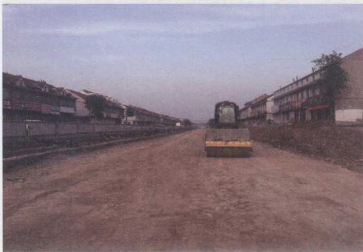
图1-2-4 换填基底平整压实处理
