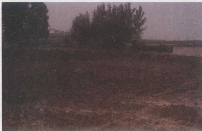
图1-2-2 机械开挖扰动原状土
