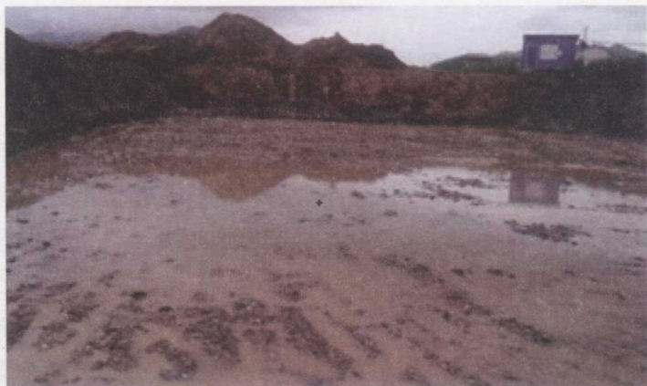
图 1-2-3 换填基底积水
