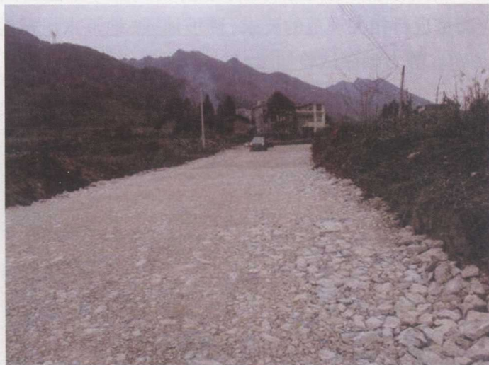
图1-2-1 粒径超标、含水率过大
