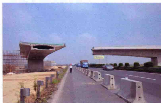
图 1-12 转体施工法
