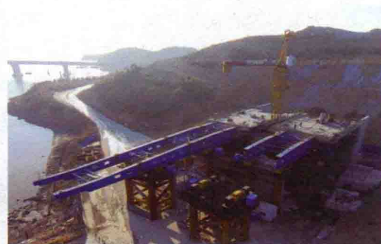
图 1-13 顶推施工法
