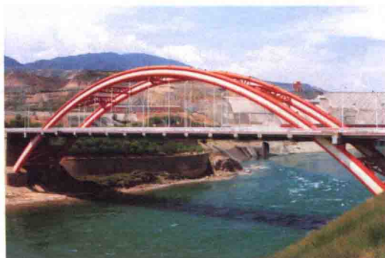
图 1-6 梁—拱组合体系桥
