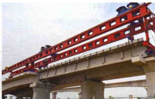
图 1-9 预制安装法
