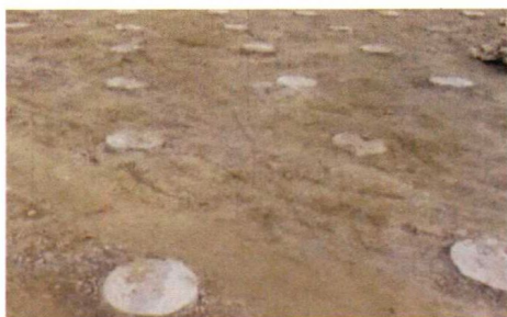
图 1.1-3 桩头切割现场效果
