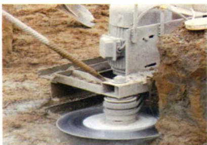
图 1.1-1 切割机环切桩头
