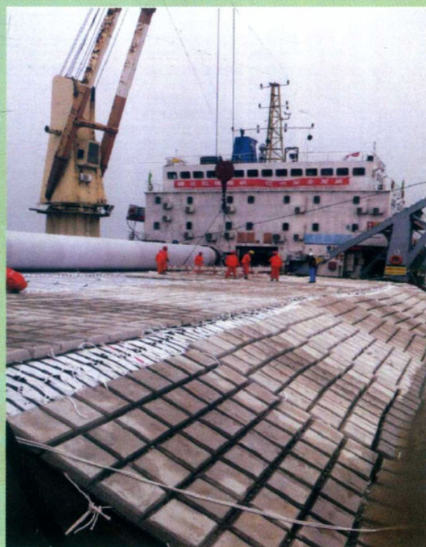
特大型软体排应用于 “长江南京以下12.5米深水航道整治工程”项目
