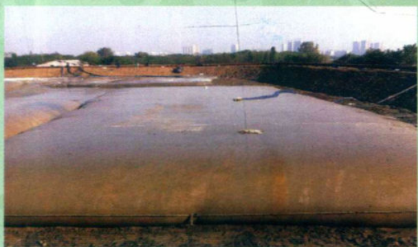
高透水性土工管袋应用于武汉径河底泥清淤工程
