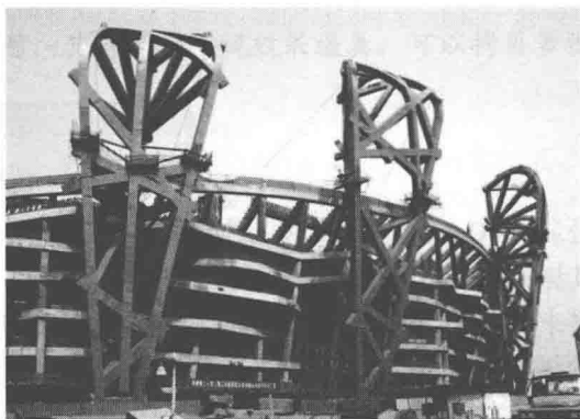
图 1-5 施工中的建筑
