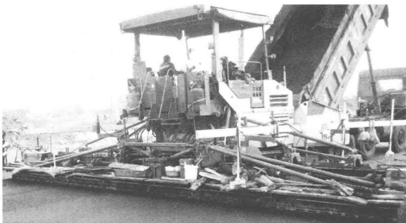
图 1-1 摊铺机施工现场
